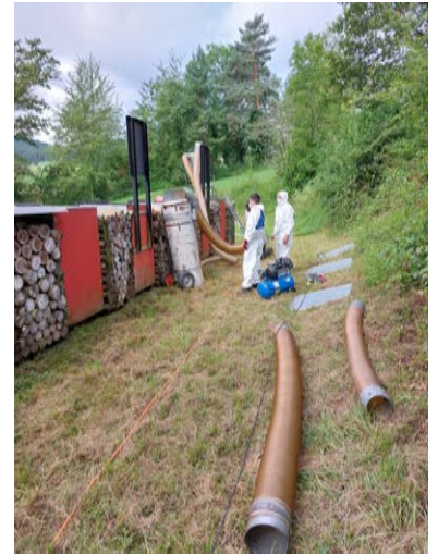
Der Bleistaub im Granulat wird durch eine Zentrifuge entfernt, danach wird das saubere Granulat wieder eingefüllt.
